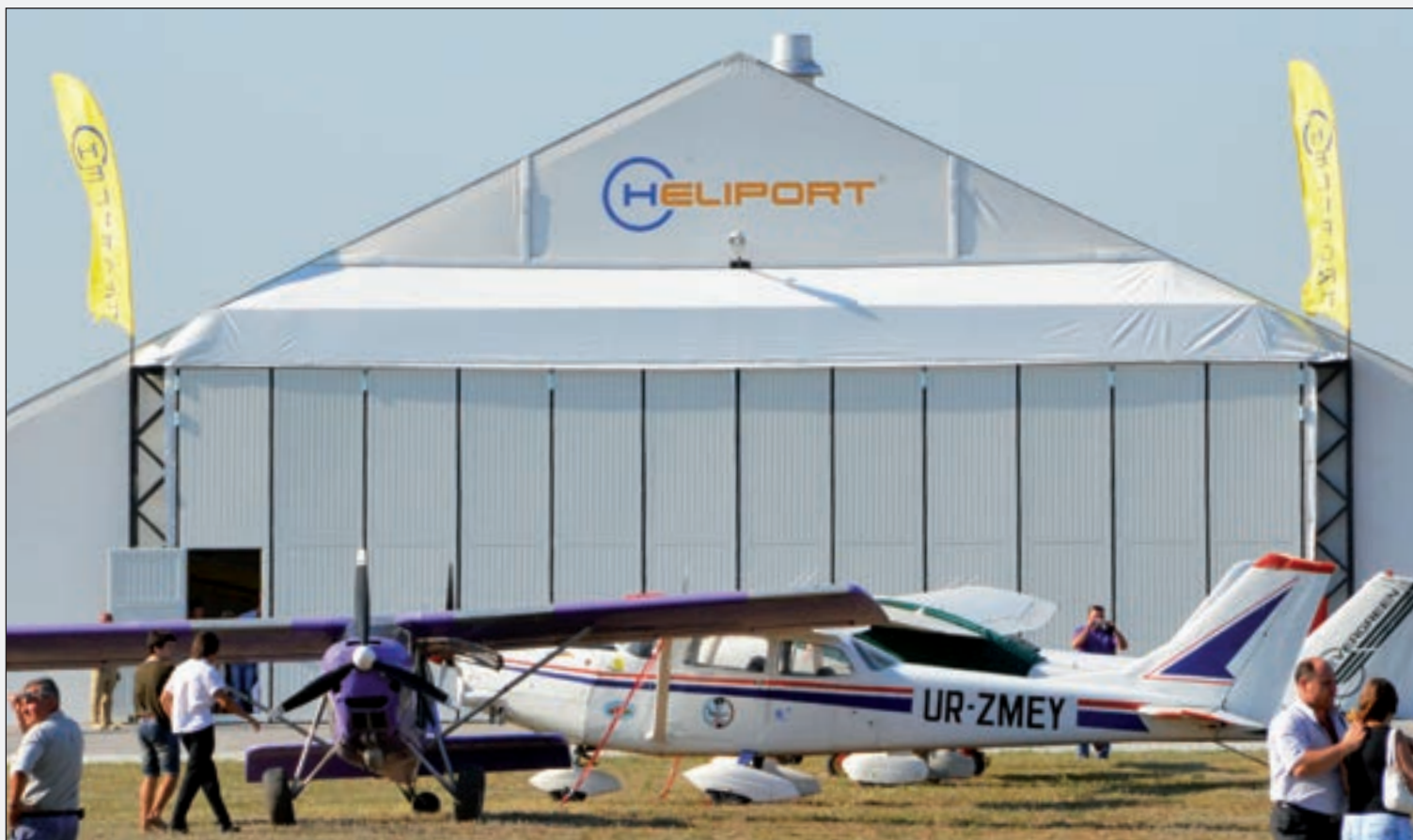
Einwandiges Falttor Typ ew RP-GUP, gesickt.
