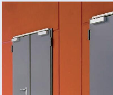
Wenn nicht nur spezifische Sicherheitsfunktionen, sondern auch der Feuerenschutz beachtet werden müssen, sind Obentürschließer Pflicht – bei zweiflügeligen Türen auch mit Schließfolgeregler. Für Novoferm Sicherheitstüren sind unterschiedliche Modelle verfügbar (zum Teil optional).
