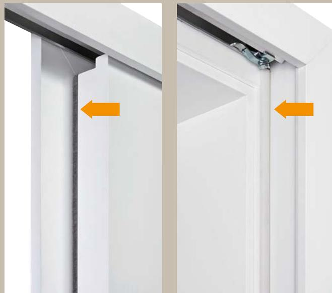
Mit der Streichbürste am Türblatt (Abbildung links) und der optionalen Einlaufdichtung im Rahmen (Abbildung rechts) bieten Ihnen die Hörmann Schiebetüren einen optimalen Schutz vor Gerüchen, Lärm und Zugluft – so fühlen Sie sich in Ihren vier Wänden noch wohler.
