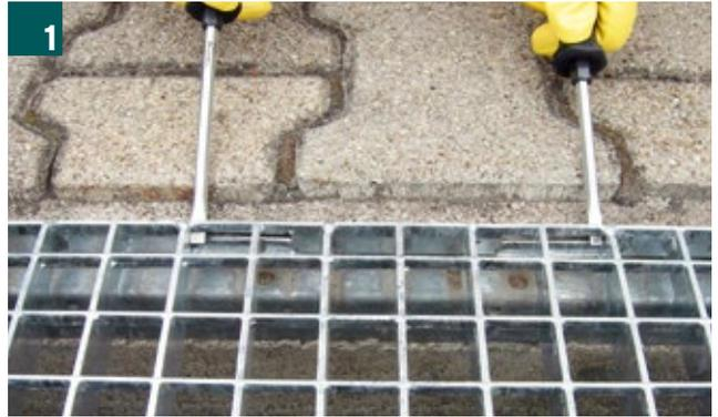
Zum Entriegeln von Gitter-, Längs- und Querstabrosten wird der Schlitz-Schraubendreher in der Mitte der Abdeckungen an beiden Tragstäben angesetzt und die Verriegelung mit einer Hebelbewegung gelöst.
