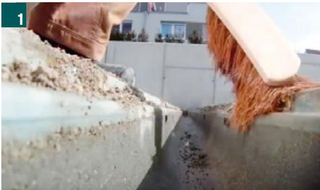
Einfach die Rostauflagefläche, sowie die Taschen der Längsschubarretierung (**SIDE-LOCK**) mit einem Besen und/oder Wasserschlauch von Schmutz befreien.
