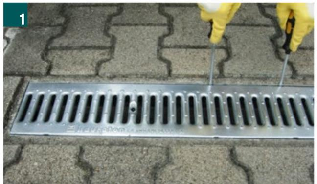
Zum Entriegeln von Steg- und Doppelstegrosten wird der Schlitz-Schraubendreher an den beiden Markierungen in der Mitte der Abdeckung angesetzt.
