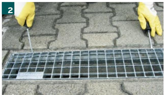
Anschließend werden die Außenseiten der Abdeckung entriegelt.
