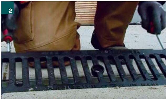
Den Schlitz-Schraubendreher leicht neigen und mit einer Hebelbewegung wird die Verriegelung gelöst.
