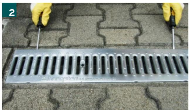
Anschließend werden die Außenseiten der Abdeckung entriegelt.
