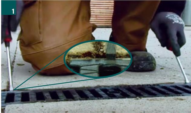
Zum Entriegeln wird der Schlitz-Schraubendreher an der Markierung angesetzt.
