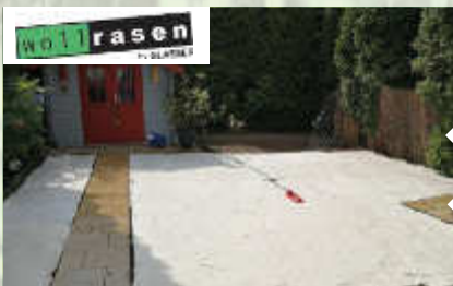
Direkt nach dem Verlegen
