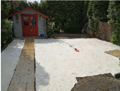
Direkt nach der Verlegung
