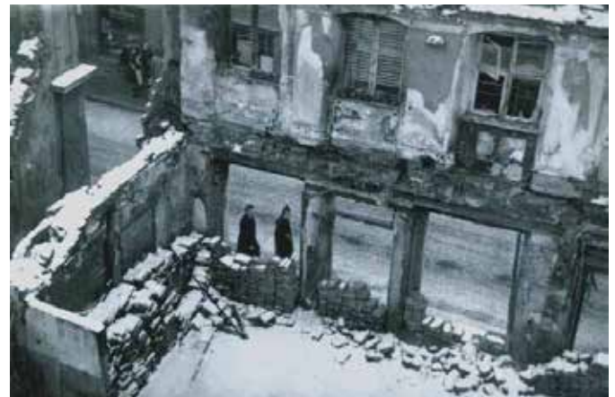
Nach dem Beschuss der Stadt Ellwangen in den letzten Kriegstagen blieb von dem Haus in der Schmiedstraße nur eine Ruine übrig. FOTO: KICHERER
