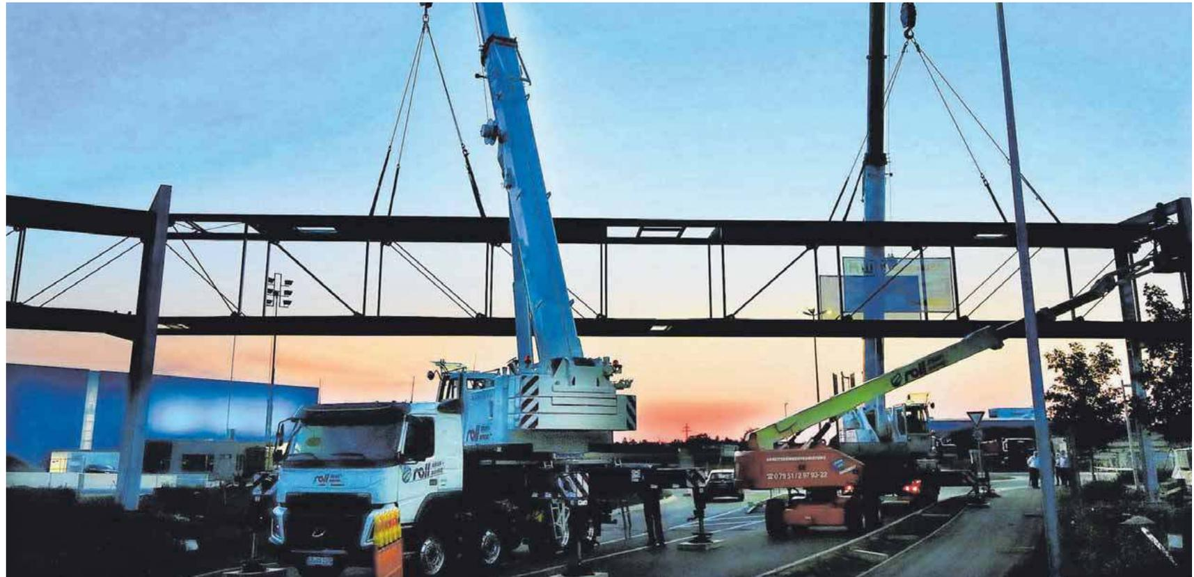
Der erste Teil der rund 74 Meter langen Brücke zwischen den beiden Verwaltungsgebäuden der Firma Kicherer ist in Neunheim an Ort und Stelle gehievt worden.
