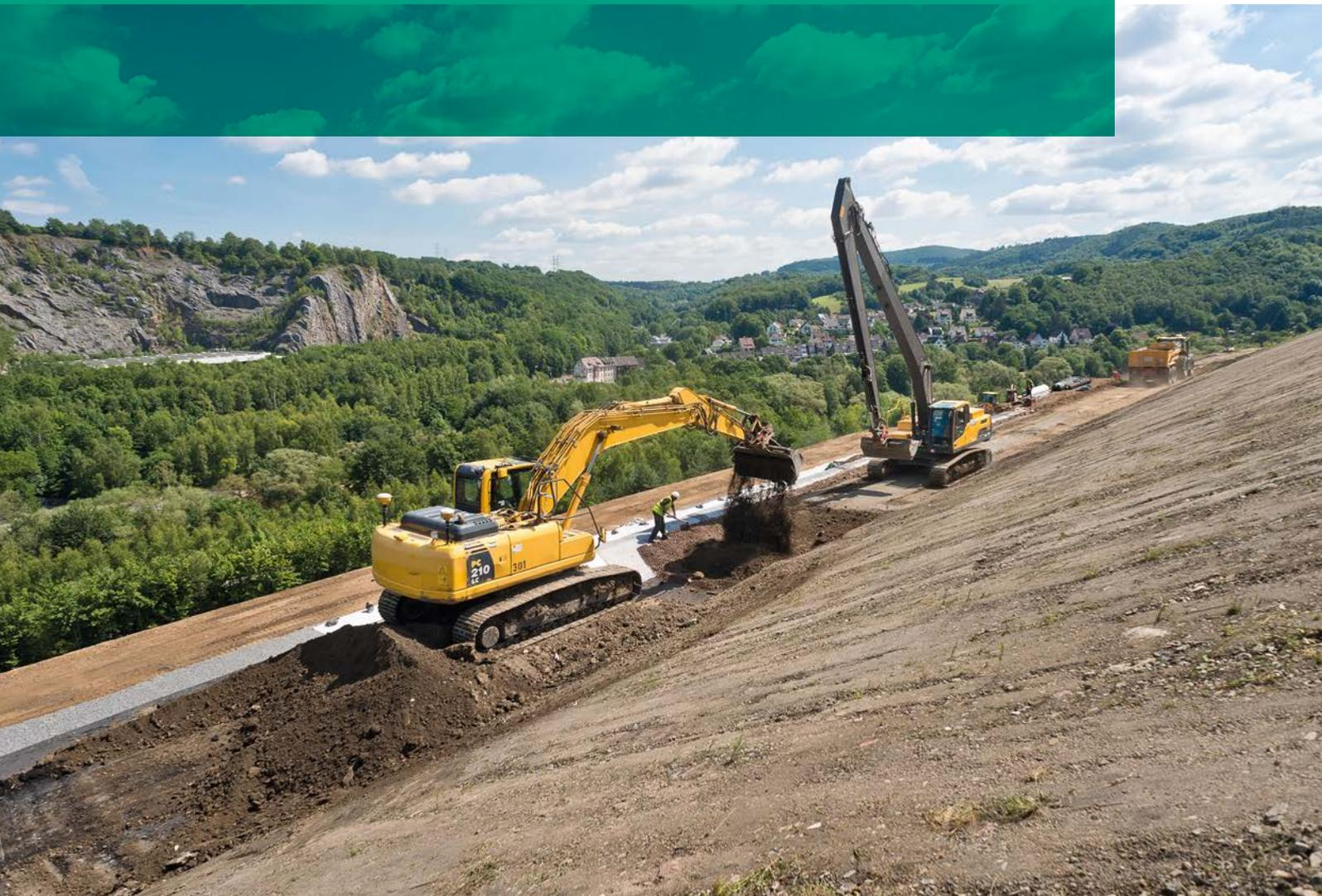
Die Produktwelt der Geokunststoffe umfasst eine Vielzahl innovativer Kunststoffprodukte für das Bauwesen. Je nach Anwendungsgebiet werden Geokunststoffe für die Funktionen Trennen, Filtern, Schützen, Bewehren, Dränen, Erosionsschutz, Verpacken und Dichten eingesetzt. Manche Produkttypen sind auch in der Lage, mehrere dieser Funktionen gleichzeitig zu übernehmen.
