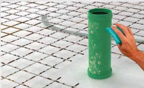
Das Rohr von Verschmutzungen und haftungsmindernden Bestandteilen (Staub, Betonspritzer, Fett etc.) mit einem Tuch säubern.
