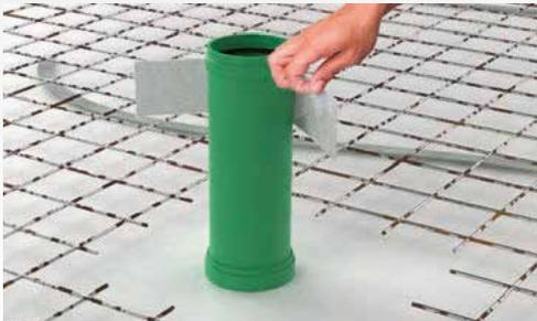
Das Sealtape in benötigter Länge abschneiden:  $\text{Außendurchmesser Rohr} \times 3,14 (\pi) + \text{mind. } 10 \text{ mm} = \text{Länge des abzuschneidenden Sealtapes in mm}$ .
