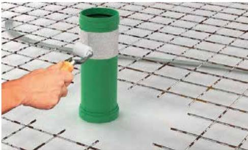
Das KG2000 Sealtape mit der Hand oder mit einer Rolle andrücken und fixieren. Durch den Gewichtsdruck des Betons entsteht während der Betonage eine feste, druckwasserdichte Verbindung.
