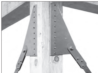
Detail an einer breiten Eckstütze: Bandanschluss BNF mit Kopplungsverbinder BNKK an Stütze. Die Abkantung wurde in die Stütze eingeschlitz.
