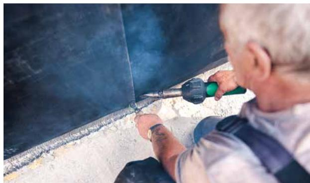
VERSCHWEISSEN DER BAHNEN MIT EINEM HEISSLUFTFÖN
