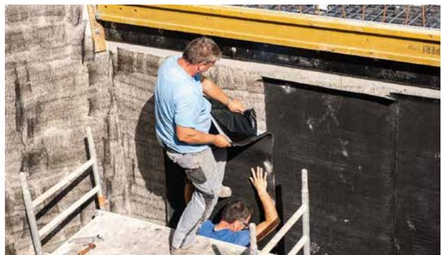
ANSETZEN UND AUSRICHTEN DER BAHN
