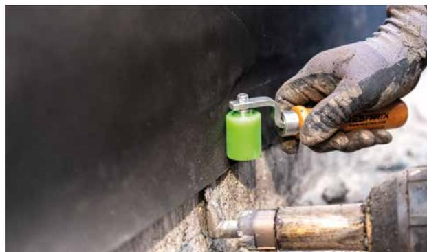
ANSCHLUSS AN BODENPLATTE MIT WINKELDÜSE
