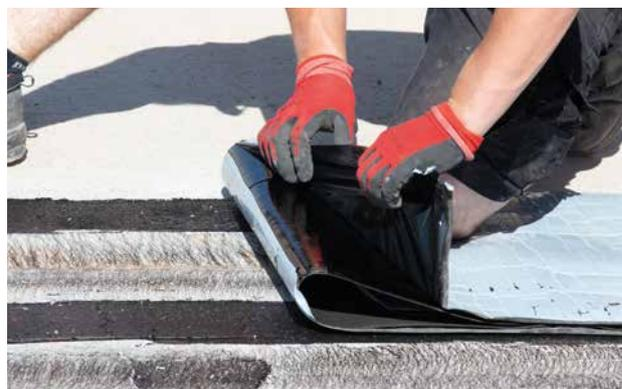
Ebenso wie bei der Flachdachabdichtung lassen sich auch in diesem Bereich alle Details einfach und sicher mit RESITRIX® SKW herstellen. Übergänge zwischen Bodenplatte und Wand werden direkt aus Bahnware zugeschnitten und eingebaut. Die verringert die auf der Baustelle benötigten Einzelteile.
