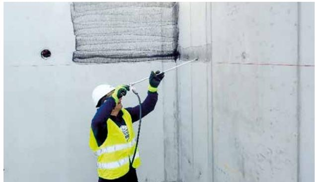
AUFSPRÜHEN VON FG 35 AUF DIE BETONOBERFLÄCHE
