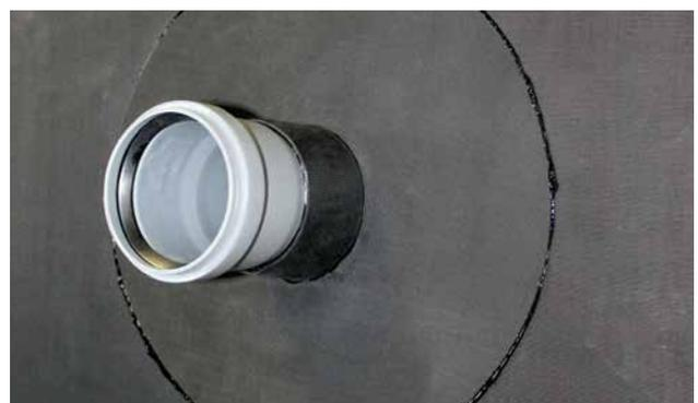
WANDDURCHFÜHRUNG BEI W<sub>1</sub>-E MIT MANSCHETTE AUS BAHNENWARE
