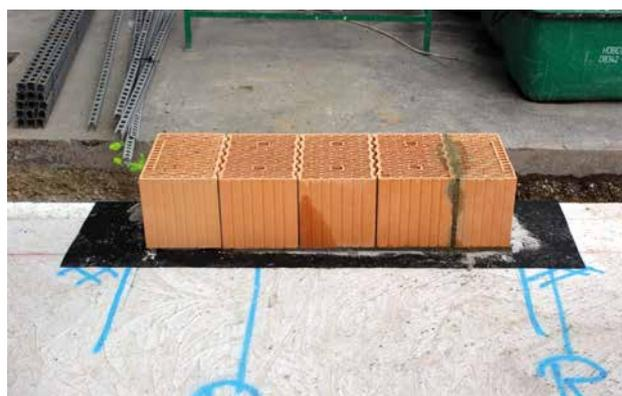
RESITRIX® kann auch zusätzlich auf der ersten Steinreihe verlegt werden, um aufsteigendes Wasser während der Bauphase oder bei Wasserschäden zu verhindern.
