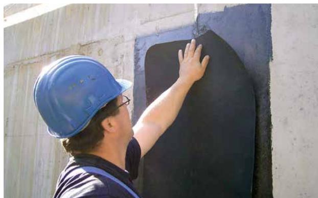
Bewegungsfugen in der Bodenplatte oder Wand können bei W1-E und bei W2.1-E mit dem Bewegungsfugenband RESIFLEX® SK ausgeführt werden. Den Untergrund entsprechend der Verarbeitungsrichtlinien vorbereiten und im Anschluss RESIFLEX® aufbringen. Danach werden die Ränder mit dem Untergrund verschweißt.
