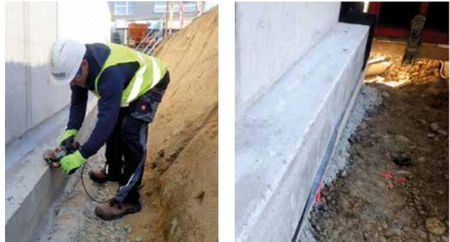
BRECHEN VON SCHARFEN KANTEN AN ALLEN ECKEN, ÜBER DENEN ABDICHTET WERDEN SOLL
