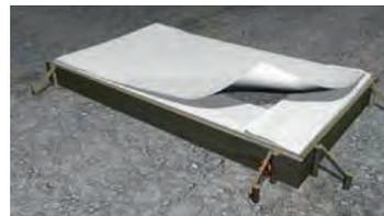
**Vor dem Betonieren folgt noch eine Schutzschicht aus PE-Folie (ab 0,2 mm) oder Geotextil (ab 150 g/m<sup>2</sup>).** Sie dient als Trennlage und verhindert später das Eindringen der Betonmilch in die Dämmschicht. Die Dämmung ist nun bereit für die Randschalung der Bodenplatte.
