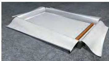
**Ein Geotextil wird auf dem Baugrund verlegt.** Es dient als Trennlage und Schutz gegen Einschlammung. Das Geotextil muss auf den Seiten so viel überstehen, dass es später über die MISAPOR-Schicht seitlich übergeschlagen werden kann. Anschliessend werden Versorgungs-/ Entsorgungsrohre und Drainage direkt auf das Geotextil gelegt.
