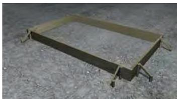
**Der Baugrund wird vorbereitet.** Für die MISAPOR-Dämmschüttung ist eine seitliche Führung vorzusehen. Es gibt verschiedene Möglichkeiten:
