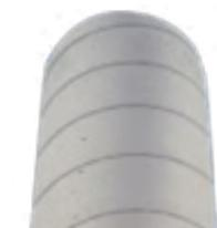
Bei der Verwendung von selbstverdichtendem Beton sind die Betoniergeschwindigkeiten zu halbieren.
