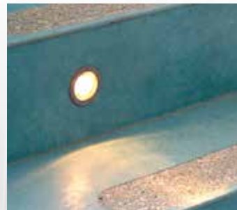
Eingebaute Spotlights / Antirutschbearbeitung
