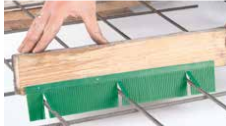
Kantholz positionieren, ausrichten und rückverankern
